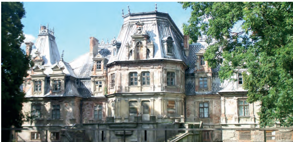
Pałac w Guzowie przed trwającym obecnie remontem, fot. Dorota Zajęc i Stanisław Hofman
